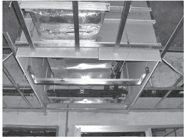
รูปที่ 4 รูปภาพการติดตั้งโครงฝ้าเพดานมารอบตัว Return Air Chamber
