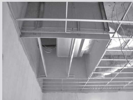
รูปที่ 6 - 7 รูปภาพการแสดงให้เห็นยิบซั่มกล่อง Return Air Chamber ที่ติดตั้งให้ต่ำกว่าฝ้าเพดาน
