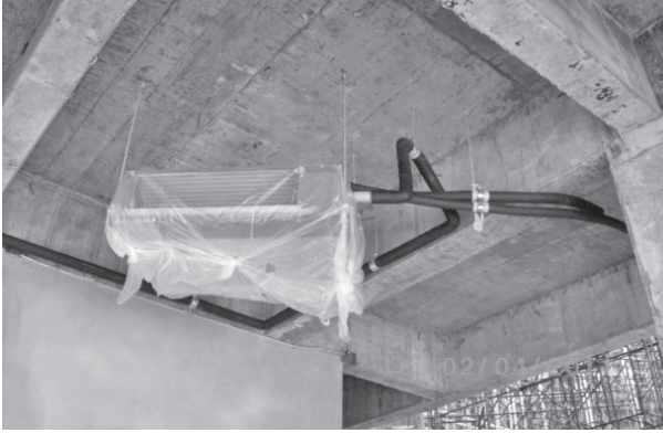
รูปที่ 1 รูปภาพการติดตั้ง FCU
