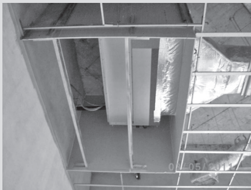
รูปที่ 8 - 9 รูปภาพการตัดแผ่นยิบซั่มกล่อง Return Air Chamber ให้เสมอกับแนวฝ้าเพดาน
