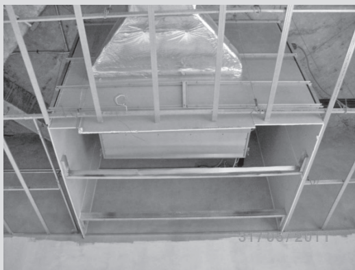
รูปที่ 6 - 7 รูปภาพการแสดงให้เห็นยิบซั่มกล่อง Return Air Chamber ที่ติดตั้งให้ต่ำกว่าฝ้าเพดาน
